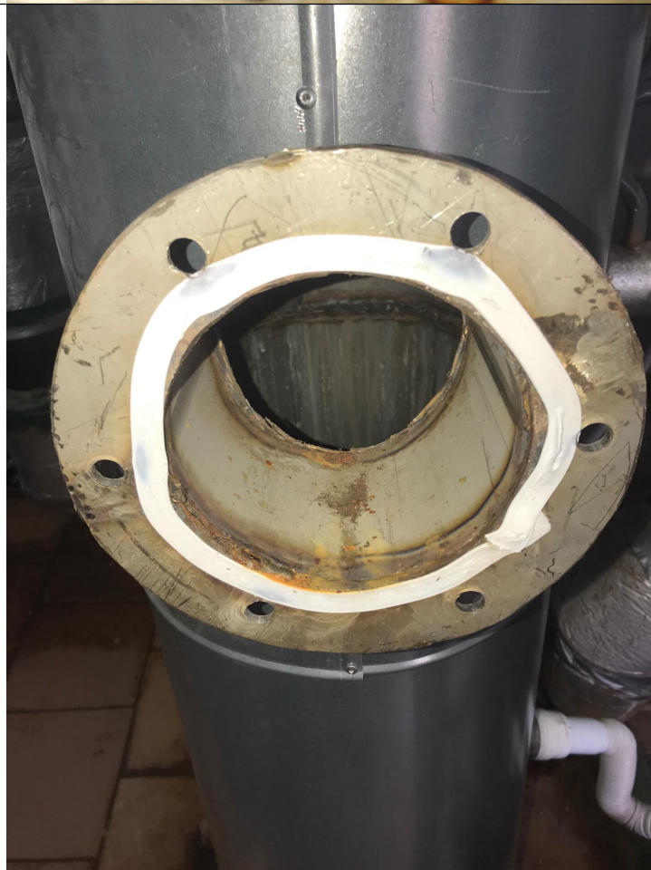
Осмотр дымовой трубы
